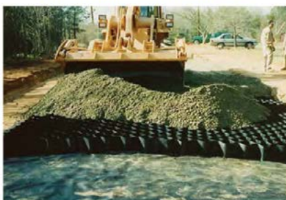
Figura 54 Espalhamento do material de preenchimento
