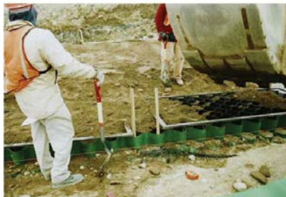
Figura 37 Preenchimento dos painéis da base
