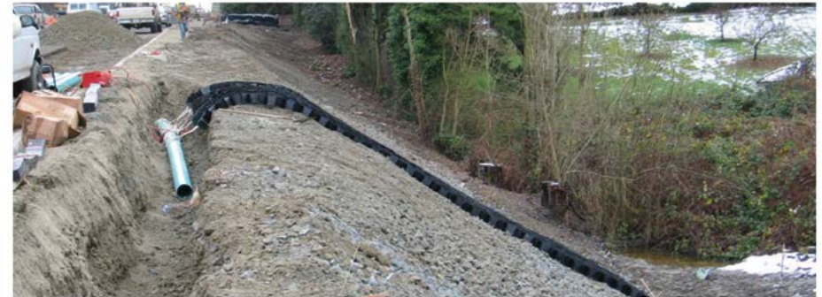
Figura 12 - Ancoragem dos cabos em canaleta na crista do talude
