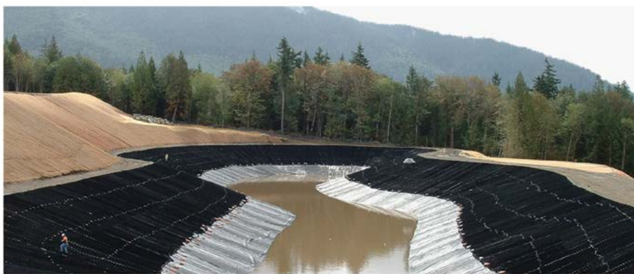
Figura 5 Geocélula StrataWeb em canal, como proteção da geomembrana
