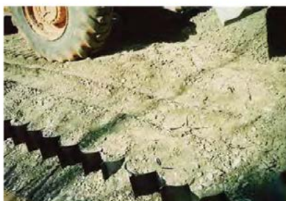
Figura 55 Compactação do material de preenchimento
