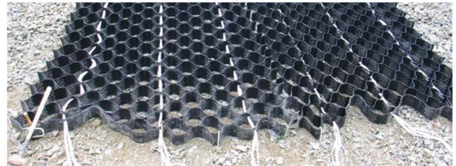
Figura 13 - Painel de StrataWeb, com cabos, colocado no talude
