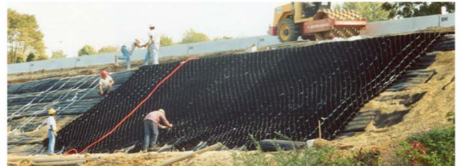
Figura 14 - StrataWeb sendo ancorada no talude
