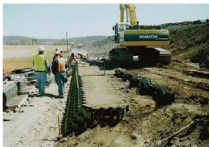
Figura 39 Muro de contenção com StrataWeb parcialmente construído
