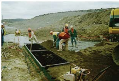
Figura 36 - Quadro de madeira para manter o painel de geocélula aberto
