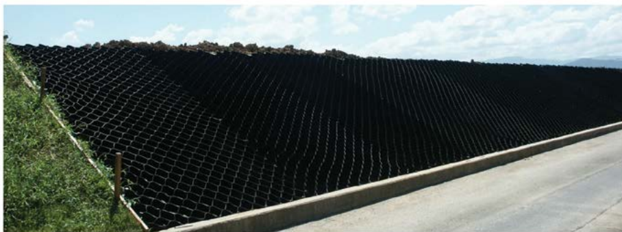
Figura 15 - StrataWeb já instalada num talude
