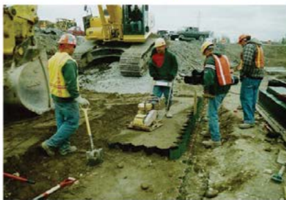
Figura 38 Compactação do material de preenchimento
