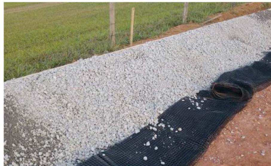
Figura 8 - Preenchimento dos contrafortes com brita
