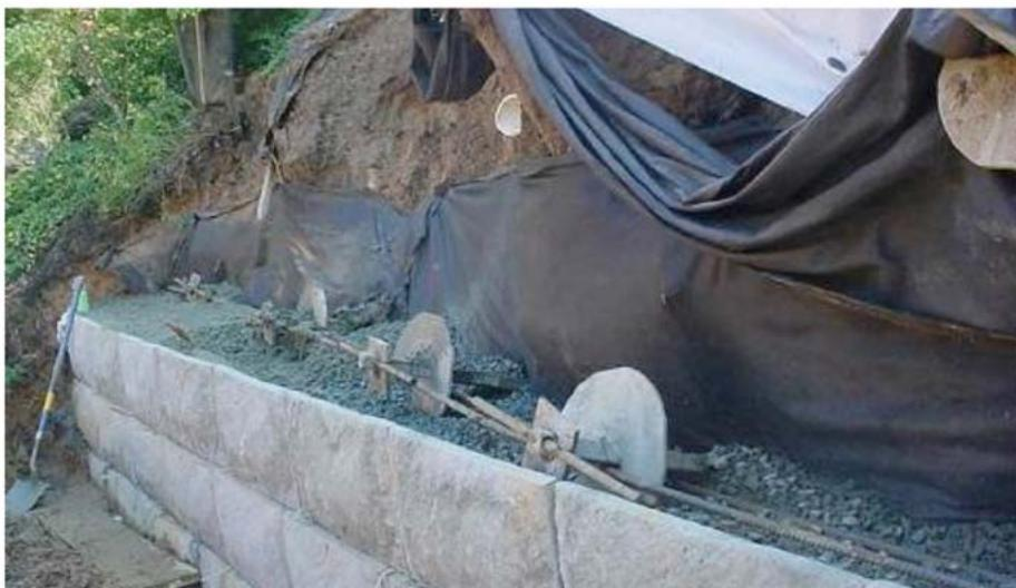
Figura 18 - Aplicação de Lock & Load®
