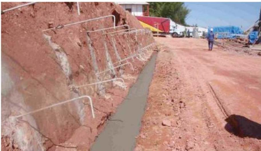
Figura 17 - Aplicação de Lock & Load®
