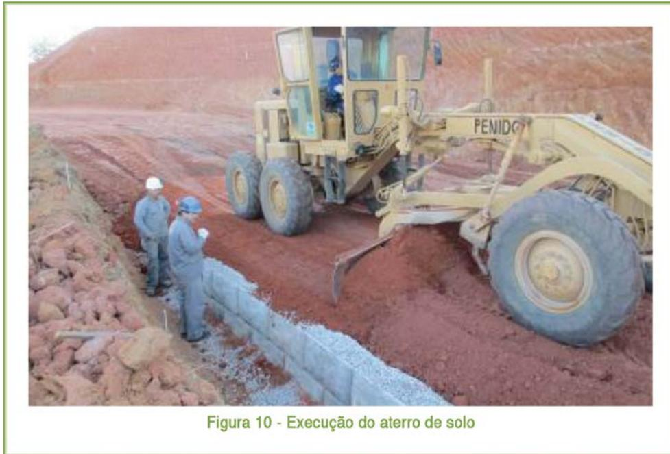
Figura 10 - Execução do aterro de solo
