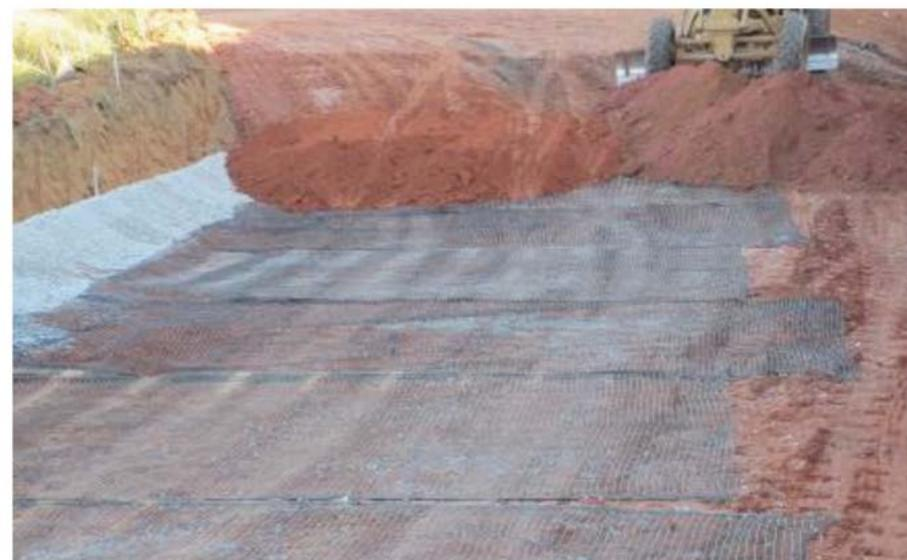
Figura 9 - Disposição do reforço de geossintético
