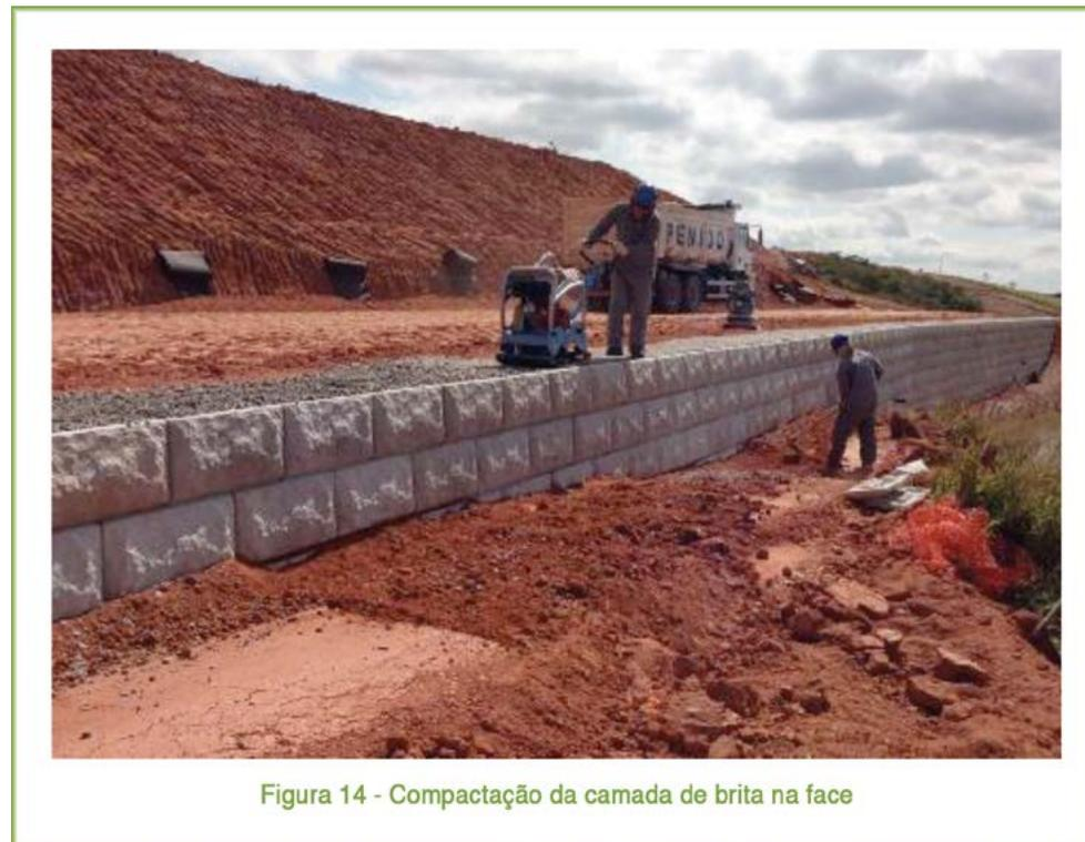
No processo de compactação é importante o cuidado com materiais rígidos, como os painéis e contrafortes, além de outras estruturas e os reforços (geossintéticos, metálicos, etc.).
