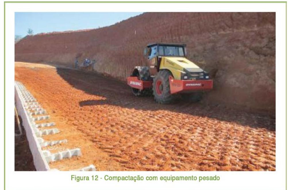
Figura 12 - Compactação com equipamento pesado
