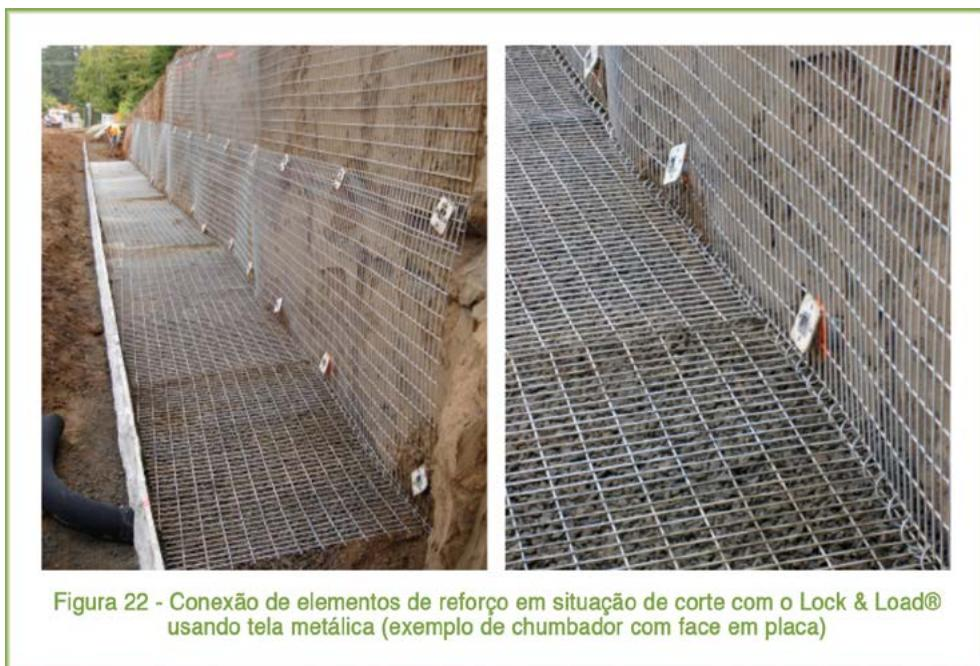
Para as respectivas etapas de escavação, compactação para nivelamento, assentamento das fiadas e drenagem do muro, consideram-se as mesmas premissas e condições relacionadas nos itens anteriores deste Manual, desde que utilizando equipamento de compactação leve. Na sequência, destaca-se a etapa de execução do sistema com sua particularidade.
