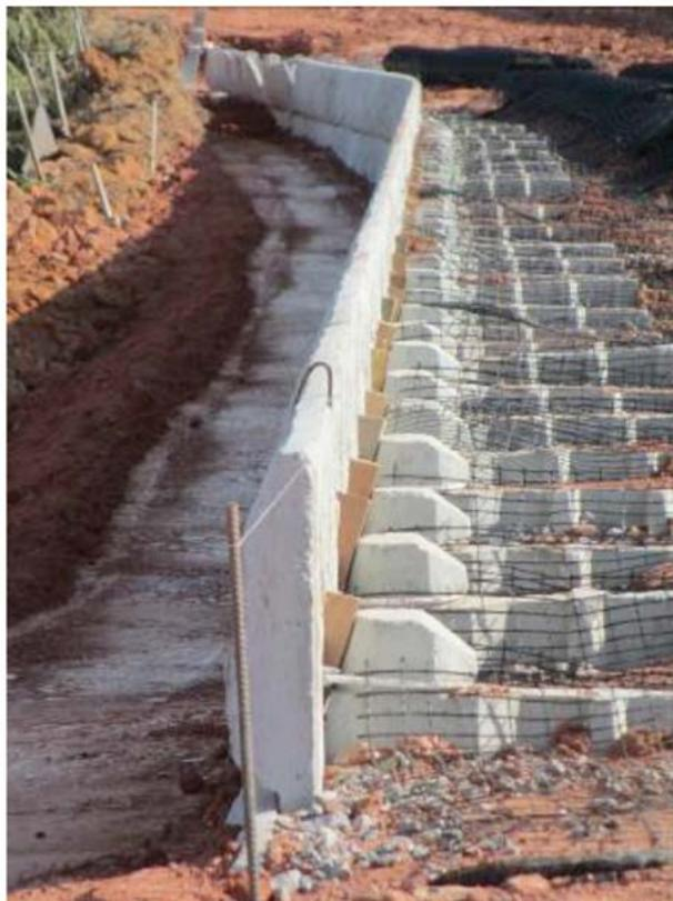
Figura 7 - Módulos alinhados na fiada
