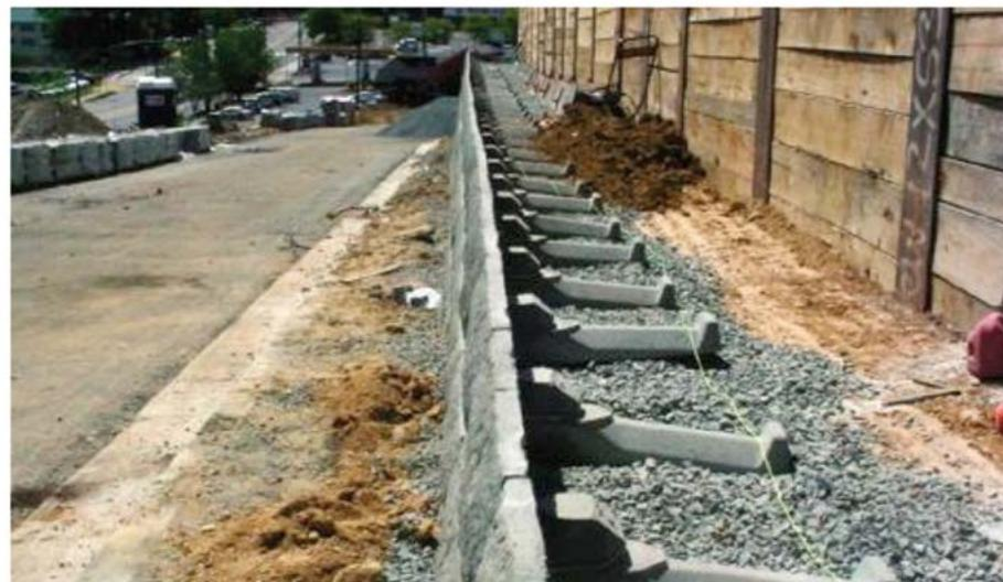
Figura 19 - Aplicação de Lock & Load®
